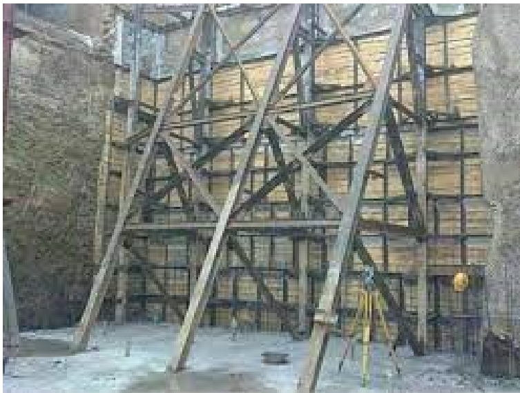
شکل ۱-۱-۱- مهار گود به روش خرپایی
