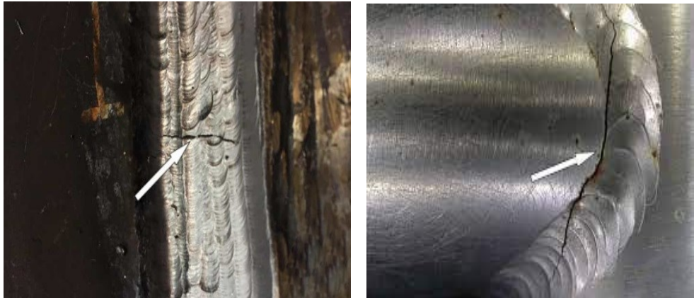
شکل ۱-۲۴- ترک در جوش
