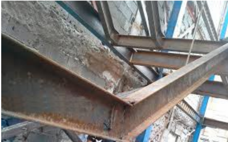
شکل ۱-۳۲- نصب تیرهای راه پله (شمشیری)
