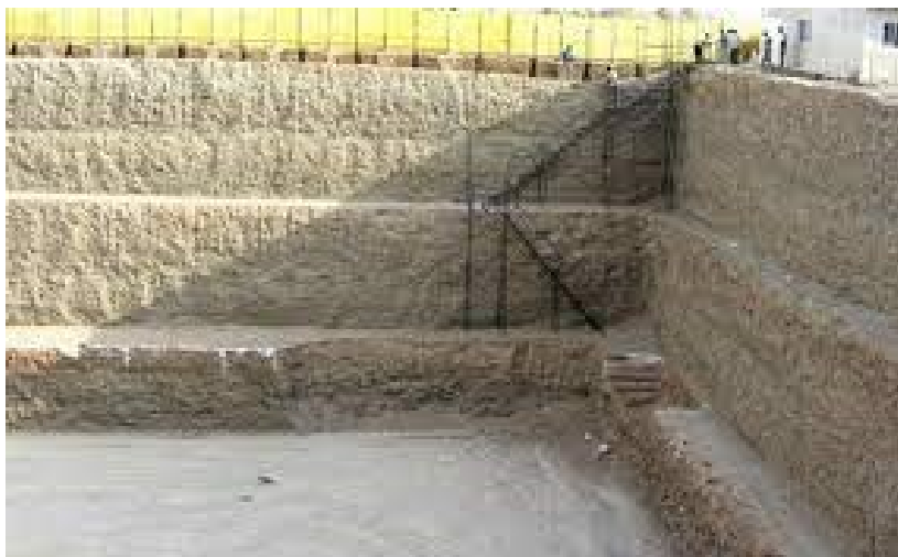
شکل ۱-۹- گودبرداری پله‌ای
