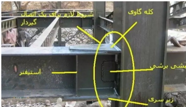
شکل ۳۱-۱- اتصال صلب تیر به ستون
