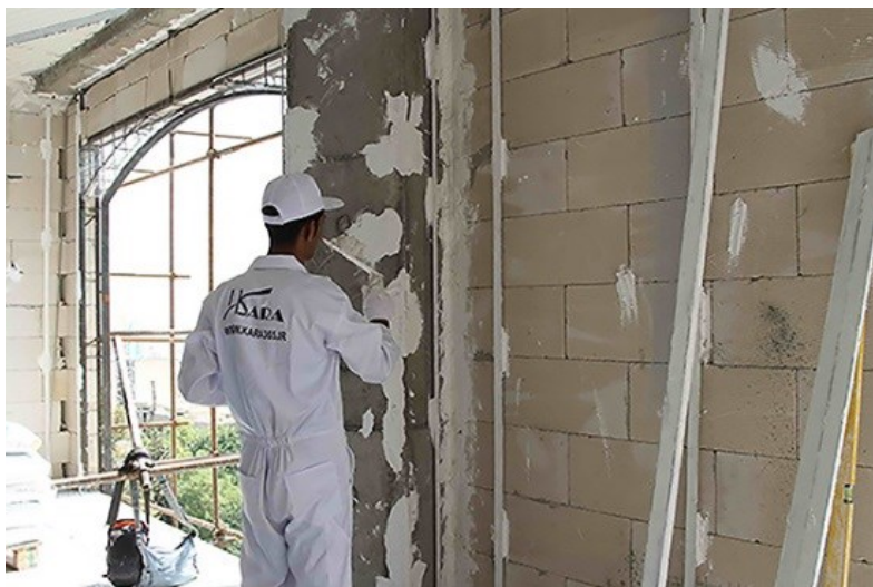
شکل ۱-۳۵- کرم‌بندی دیوارها
