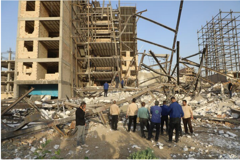
شکل ۱-۸- تخریب غیر اصولی
