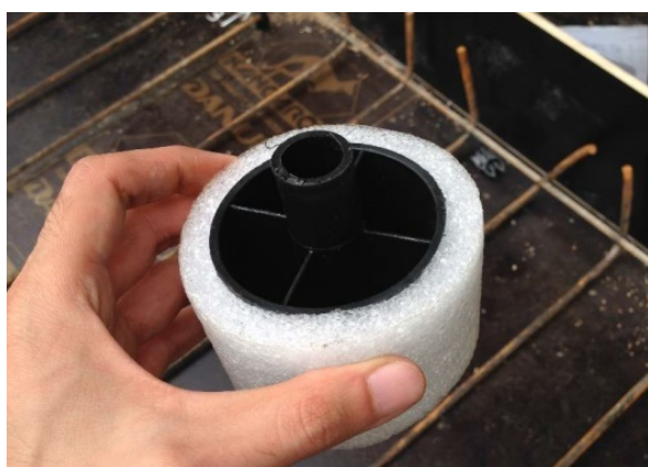
الف) گیره کششی و قالب حفره ی جلوی گیره در سیستم نچسبیده
