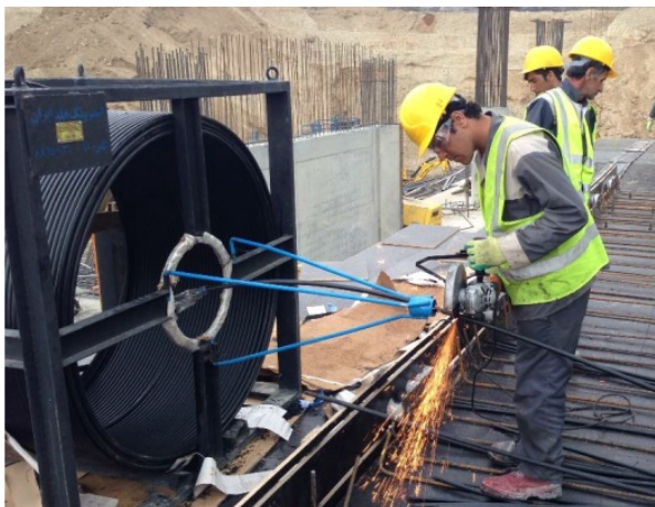
پ) قرقره تاندون‌ها و باز کردن تاندون‌ها و جایگذاری آن‌ها توسط ابزار هدایت از روی قرقره (انتهای مرده تاندون در فاصله ۵۰ میلی‌متری قالب جداره قرار می‌گیرد)
