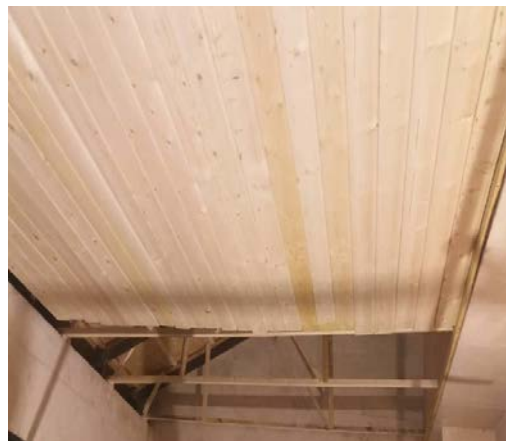
شکل ۸-۷۰- زیرسازی با چهارتراش‌های چوبی به فواصل حداکثر ۶۰۰ میلی‌متر که توسط پیچ به پروفیل‌های فولادی سقف سازه متصل شده است
