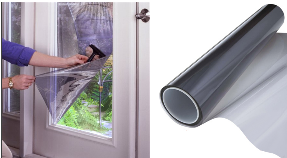
شکل ۱۲-۸۰- نصب فیلم پنجره بر روی شیشه پنجره‌های موجود
