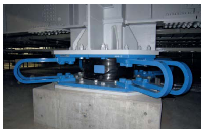
(ب) میراگر تسلیمی فولادی U-شکل
