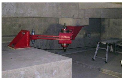
(پ) میراگر اصطکاکی
