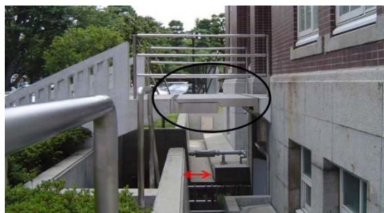
ایجاد قابلیت تغییر مکان جانبی و قائم در محل پله دسترسی با ایجاد شیار
