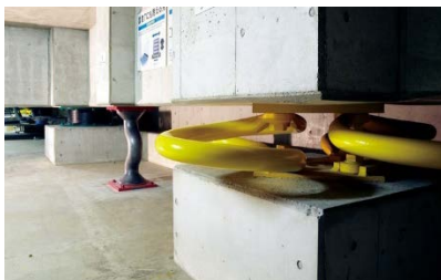
(ج) میراگر تسلیمی سربی و تسلیمی فولادی
