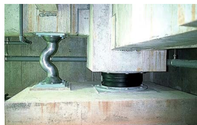
(الف) میراگر تسلیمی سربی
