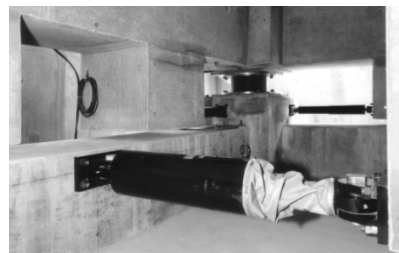
(ت) میراگر ویسکوز
