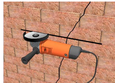
الف) ایجاد شیار در درز دیوار به کمک فرز
