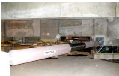
(ث) میراگر ویسکوز و تسلیمی فولادی
