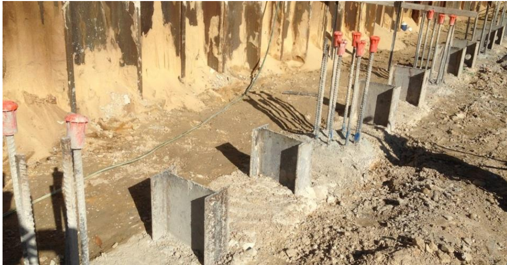
شکل ۳-۶۵ افزایش ظرفیت خمشی ستون‌های خاک - سیمانی با فرو راندن مقاطع فولادی I شکل و همچنین شبکه میلگرد داخل مخلوط خاک - سیمان پیش از گیرش سیمان
