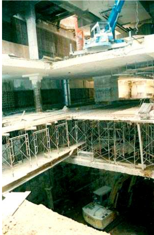
شکل ۳-۷۱ انجام عملیات خاکبرداری به اندازه ارتفاع دو طبقه زیرزمین جهت تسریع در سرعت عملیات خاکبرداری و ایجاد فضای کاری بیشتر برای استقرار ماشین‌آلات بزرگتر
