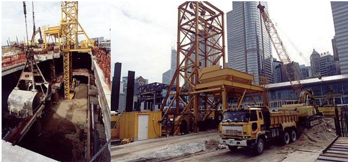
شکل ۴-۱ انجام حفاری طبقه زیرزمین. خاک در زیر تراز دال طبقه همکف حفاری می‌شود. کامیون‌ها برای حمل خاک در بالا و تراز زمین کنار بالابر خاک قرار می‌گیرند.
