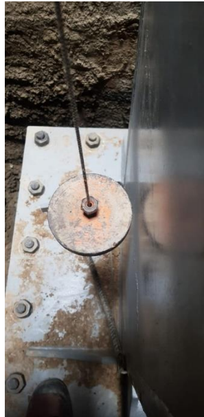
شکل ۳-۲۶ انتقال نقاط محور ستون پیاده شده در سر چاه به پایین چاه و سر شمع جهت نصب و شاقولی ستون مستقر بر صفحه‌ستون
