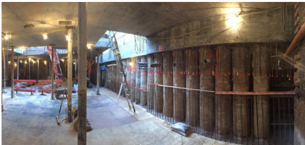
شکل ۳-۹۵ اجرای یک دیوار حائل بر روی دیوار حائل مدفون شمعی به صورت مرحله‌ای و از بالا-پایین
