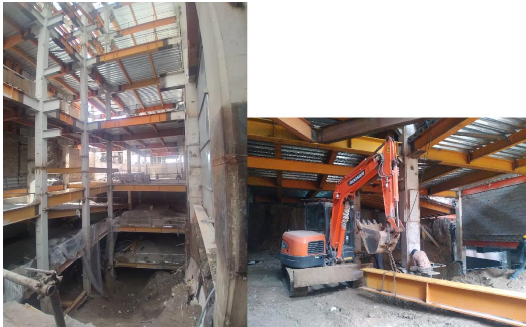
شکل ۱-۱۶ پروژه پاسداران - الگوی بومی - اسکلت فلزی- سقف عرشه فولادی- عمق گودبرداری ۱۸ متر.
