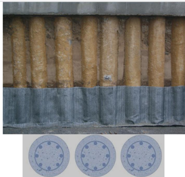
شکل ۳-۵۱ نما و مقطع دیوار شمع‌های متصل که بین هر دو شمع فاصله‌ای وجود دارد و جبهه خاک بین دو شمع باید بتواند پایدار باقی بماند
