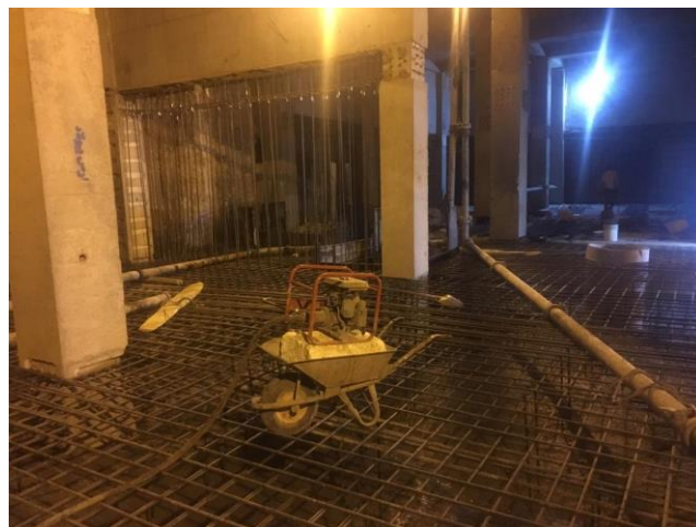
شکل ۳-۱۱۴ اجرای پی در ستون‌های پیش‌ساخته بتنی و اتصال میلگردهای پی به وصله‌های انتظار از پیش موجود در ستون‌ها
