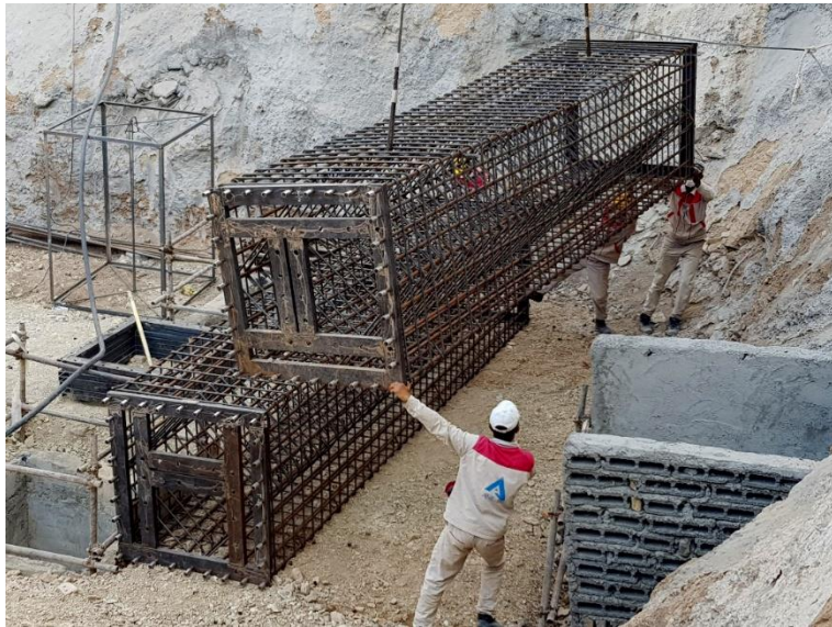
شکل ۳-۸ سبد میلگرد بافته شده به شکل مربع و استفاده از شابلون فولادی جهت ایجاد صلیبیت و یکپارچگی سبد و همچنین اتصال میله-مهارهای صفحه‌ستون به سبد میلگرد شمع
