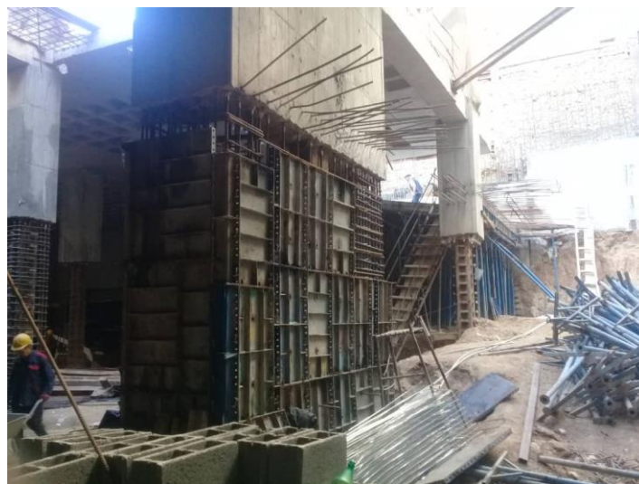
شکل ۳-۱۰۶ قالب بندی دو طرفه و اجرای از بالا-پایین دیوار برشی
