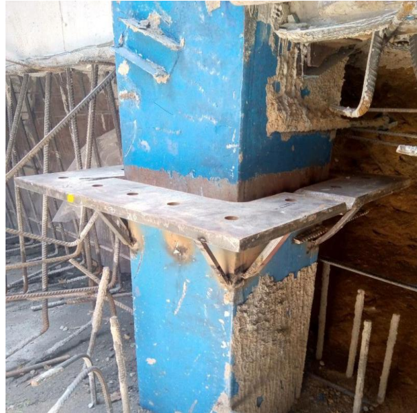
شکل ۳-۱۱۵ استفاده از یک صفحه ستون دو تکه بر روی تراز پی در ستون فولادی
