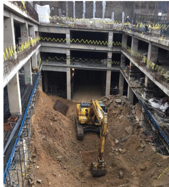
شکل ۱-۱۳ پروژه پارکینگ طبقاتی نیاپش - الگوی بومی - اسکلت بتنی با ستون‌های پیش‌ساخته - عمق گودبرداری ۳۵ متر
