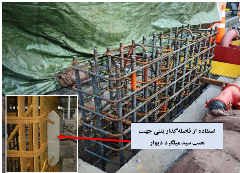
شکل ۳-۴۳ فاصله‌گذار بتنی در احداث دیوار بتنی
