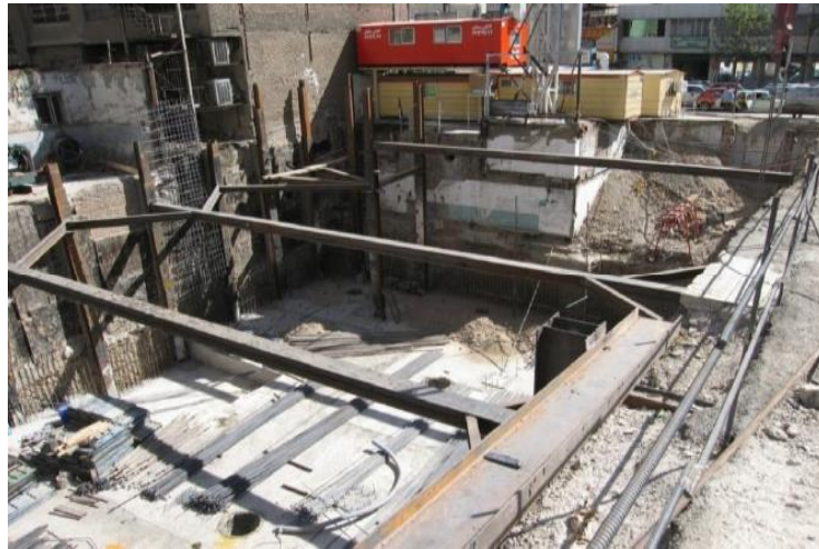
شکل پ ۱-۶ پایدارسازی گود با روش مهارمتقابل
