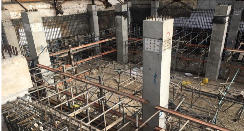
شکل ۳-۱۰۳ مهار قالب یکطرفه دیوار حائل به ستون‌های میانی سازه با شاسی‌کشی فولادی
