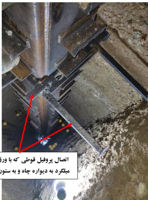
شکل ۳-۲۰ استفاده از دو پروفیل قوطی به صورت متعامد در بر ستون و جوش دادن آنها به ستون و مهار کردن قوطی به دیواره چاه به منظور ثابت کردن بخش تحتانی ستون فولادی در روش نصب معلق.
