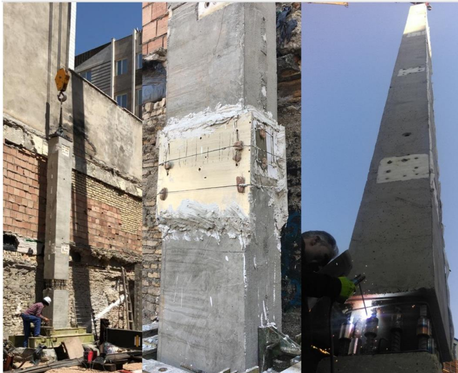
شکل ۳-۲۴ انجام وصله ستون پیش ساخته بتنی به کمک وصله مکانیکی و استفاده از گروت ریزی
