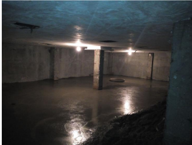
شکل ۳-۱۲۶ نمونه اجرای بتن آب‌بند بر روی فونداسیون
