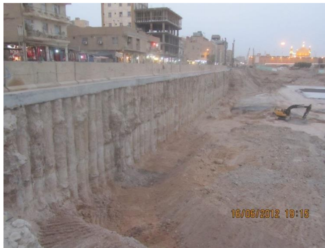
شکل پ ۱-۱۱ پایداری گود با روش شمع مماسی
