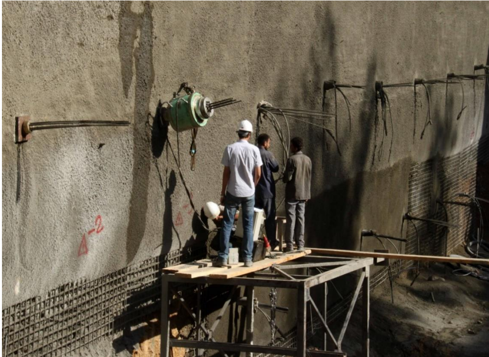
شکل پ ۱-۱۷ پایدارسازی گود با مهاربندی دیواره
