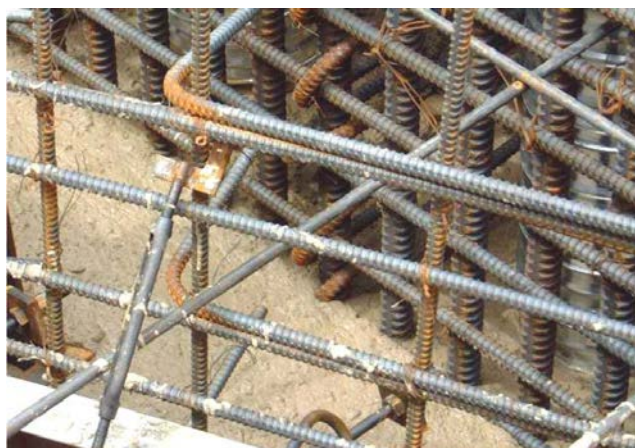
شکل ۱-۵ قابلیت عبور و پر کنندگی SCC در مقطعی با حجم زیاد میلگرد
