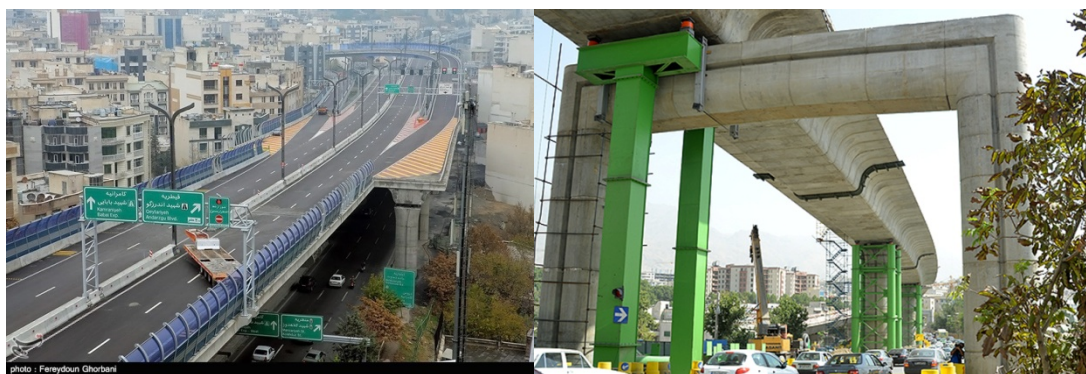
شکل ۳-۱ نمایی از پل صدر (سمت چپ) و پایه‌های دروازه‌ای که با استفاده از بتن خودتراکم ساخته شده‌اند (سمت راست)
