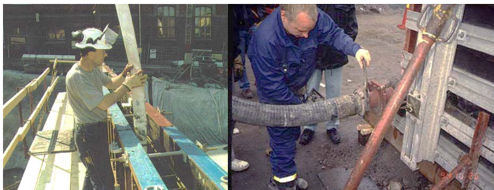
شکل ۳-۷ روش بتن‌ریزی در دیوار (سمت راست، بتن‌ریزی از قسمت پایین دیوار و چپ، شروع بتن‌ریزی از قسمت وسط دیوار)
